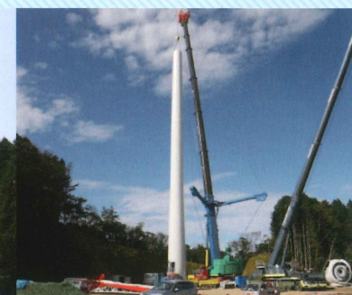
3 トップタワー据付
