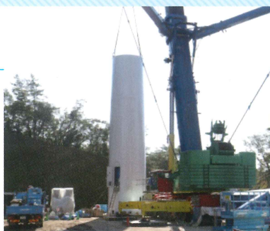
1 ボトムタワー据付
