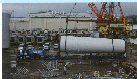
1 タワー陸揚げ
