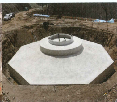
4 コンクリート外観
