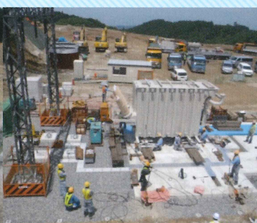
2 機器据付(コロ引き)
