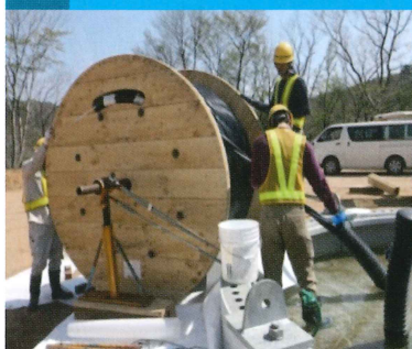
3 ケーブル布設
