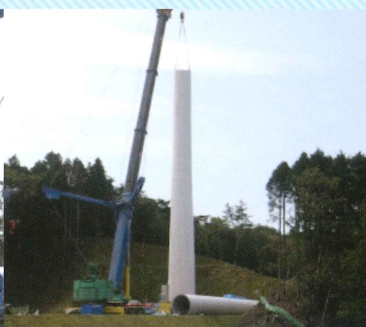
2 ミドルタワー据付
